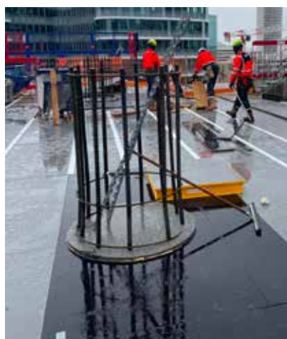
Alphi peut dimensionner et fabriquer des éléments spéciaux pour répondre aux besoins spécifiques du chantier. Ici : un coffrage poteau
