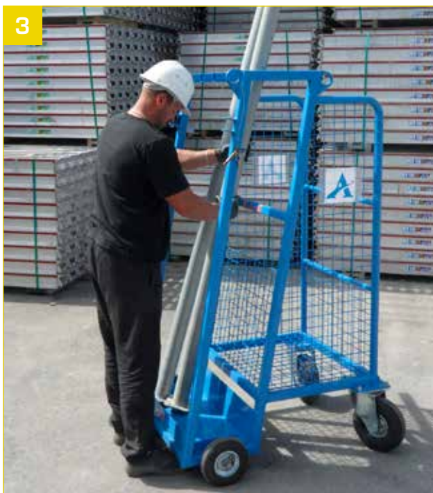
- Positionnement des étais dans le chariot.
