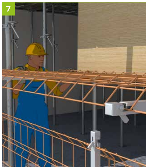
- S'assurer que la grille soit bien en place dans les emplacements en sommet et pied de potelets.
